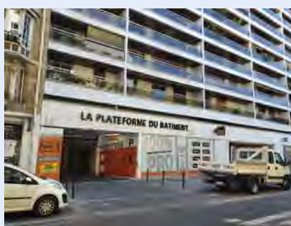
Plateforme du bâtiment - Rue Gros - Paris (16 ème )
